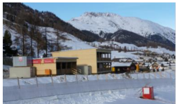
Erstellen von Infrastrukturen Bob-WM 2013 in St. Moritz
