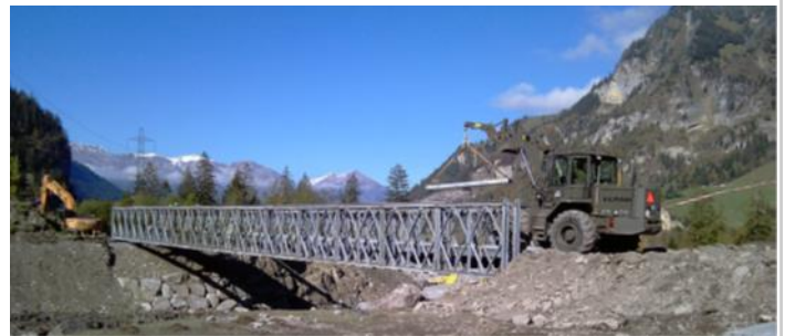
Einbau einer Notbrücke im Kandertal 2011
